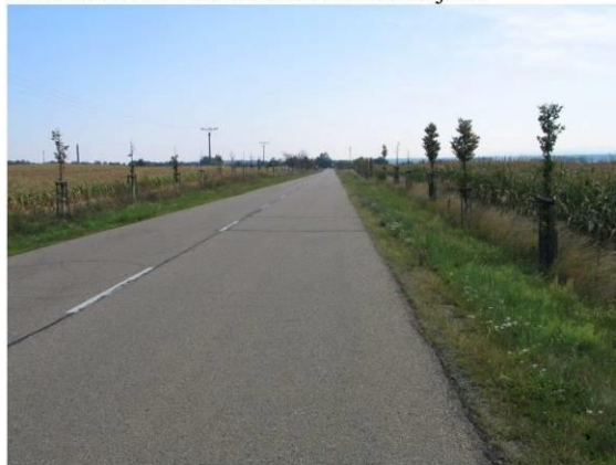
Foto 13: Pohled na na koridor K-D2 od jihu.
